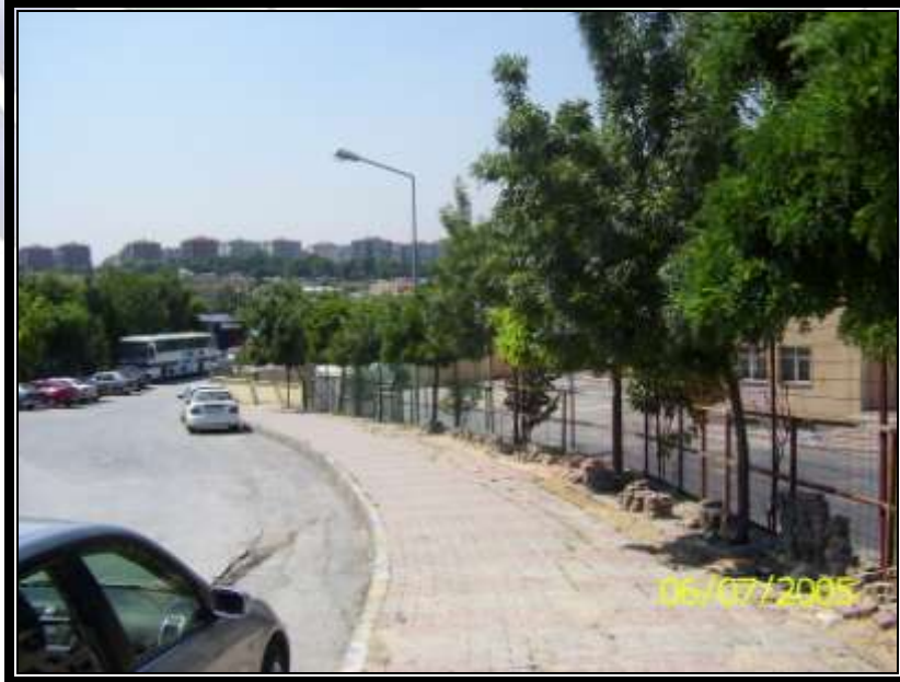
Osmaniye Mahallesi Tretuvar Parke Taşı Onarım Çalışması
