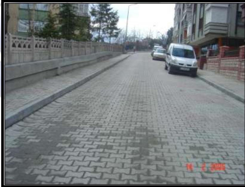
Osmaniye Mahallesi Fildamı Çobançeşme Sokak Parke Taşı Yapımı
