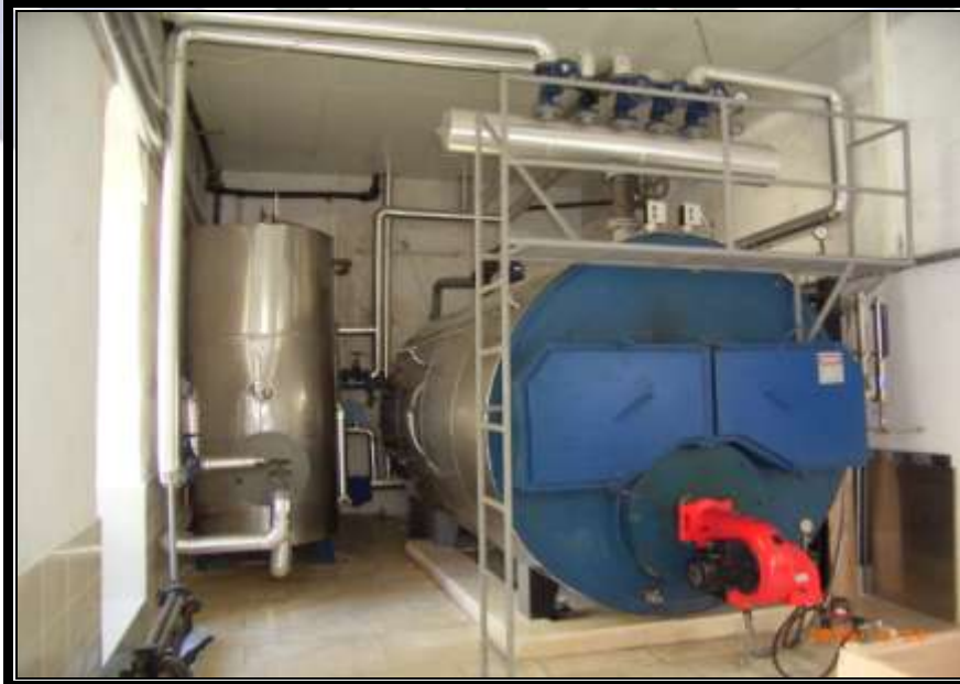
Osmaniyeh Gençlik ve Spor Köyü Tesisi Isıtma ve Sıhhi Tesisat Yapımı
