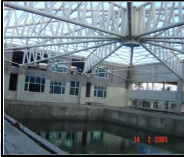
Osmaniye Gençlik ve Spor Köyü Tesisi Yüzme Havuzu Çelik çatı İmalatı yapımı
