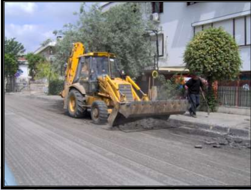
Basıncıköy Mahallesi Asfalt Çalışması
