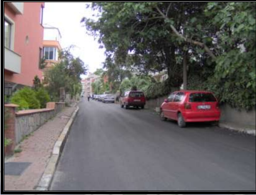
Basinköy Mahallesi Asfalt Çalışması
