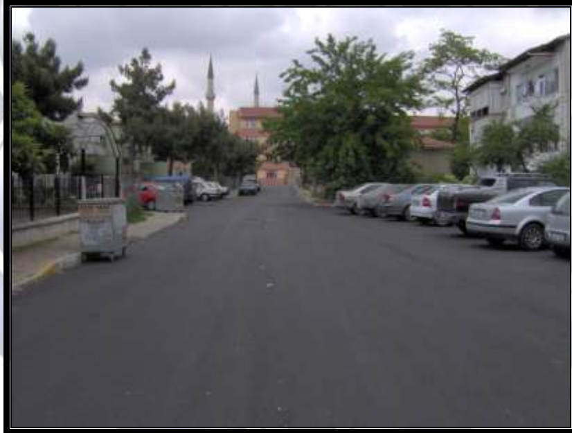
Yeşilköy Mahallesi Asfalt Çalışması
