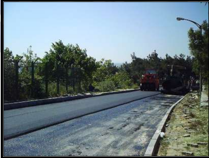
Şenlikköy Mahallesi Asfalt Çalışması
