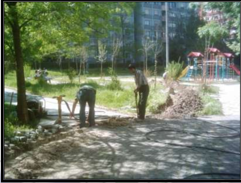
Ataköy 9. Kısım Elektrik Tesisatı Yenileme Çalışması
