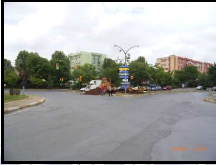
Atak y Mahallesi Trafik İşaret Levhası D zenlemesi ve Asfalt  alışması
